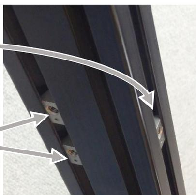
ポールのレールA,Bの部分に2個ずつ、Cの部分に1個にイージーナットを入れる
