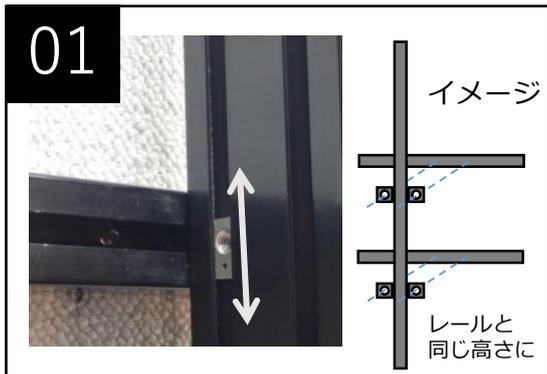
ポールをレールにあて、ポールのイージーナット4ヶ所の高さをレール合わせて調整する
