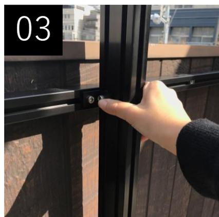
03 設置したい位置までずらし六角レンチで六角穴付きボルトを締めて固定する
