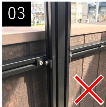
横向きに取り付けてしまうと強度が足りなくなる可能性があるため、必ず縦に設置する
