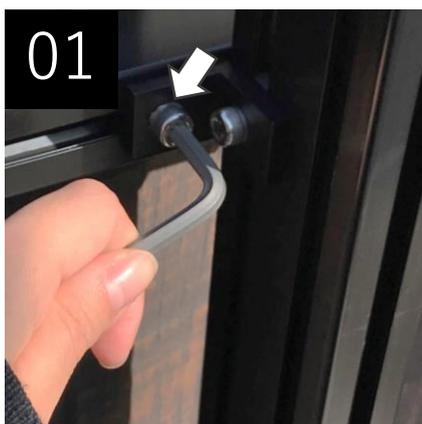
六角レンチを用意し、レールに固定する六角穴付ボルトを締めて固定する
