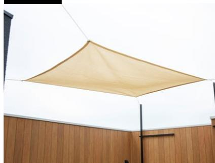
スナップフックを多機能ポールのアイボルトと、塔屋壁面のアイプレートにかける
