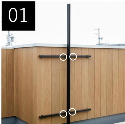
六角レンチを用意しレールに固定している六角穴付ボルトを外す
