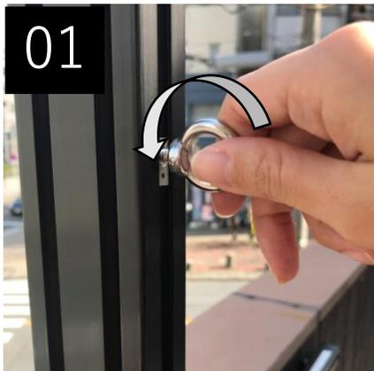
01 アイボルトを持ち反時計方向に回し、アイボルトを緩める
